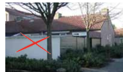
Bijgebouwen op het achtererf gemaakt van plaatmateriaal: moet getoetst worden
