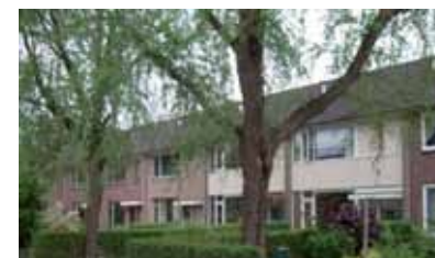
Afwijkend materiaalgebruik, maar waarbij de bestaande vormen van de gevelopeningen niet zijn veranderd: goed.
