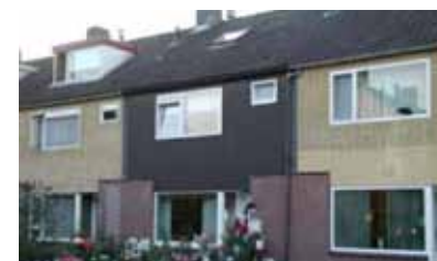
Afwijkend materiaalgebruik, maar waarbij de bestaande vormen van de gevelopeningen niet zijn veranderd: goed.
