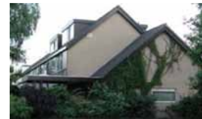
Overkapping aan de zijkant die plat afgedekt is: goed.
