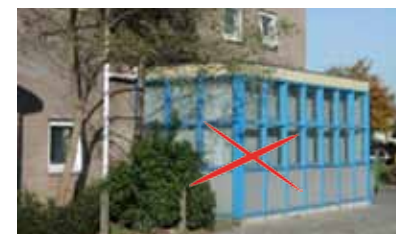
Aanbouw die in kleur en- materiaalgebruik niet goed aansluit
