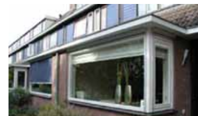
Uitbouw die in hoogte en breedte goed aansluit op de goothoogte van het gebouw.
